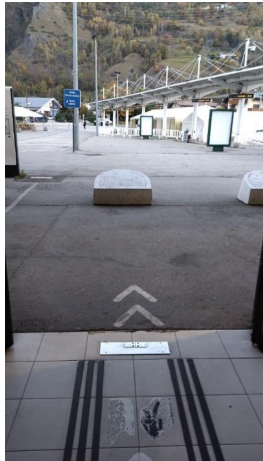
Gare de Bourg-Saint-Maurice : sortie en direction de la gare routière. Les lignes de guidage s'arrêtent aux portes automatiques.
