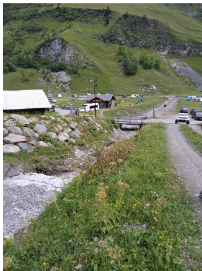
Vue après intervention - Les Chapieux
