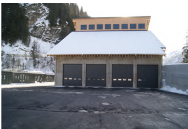
Quai de transfert des déchets des Brévières
