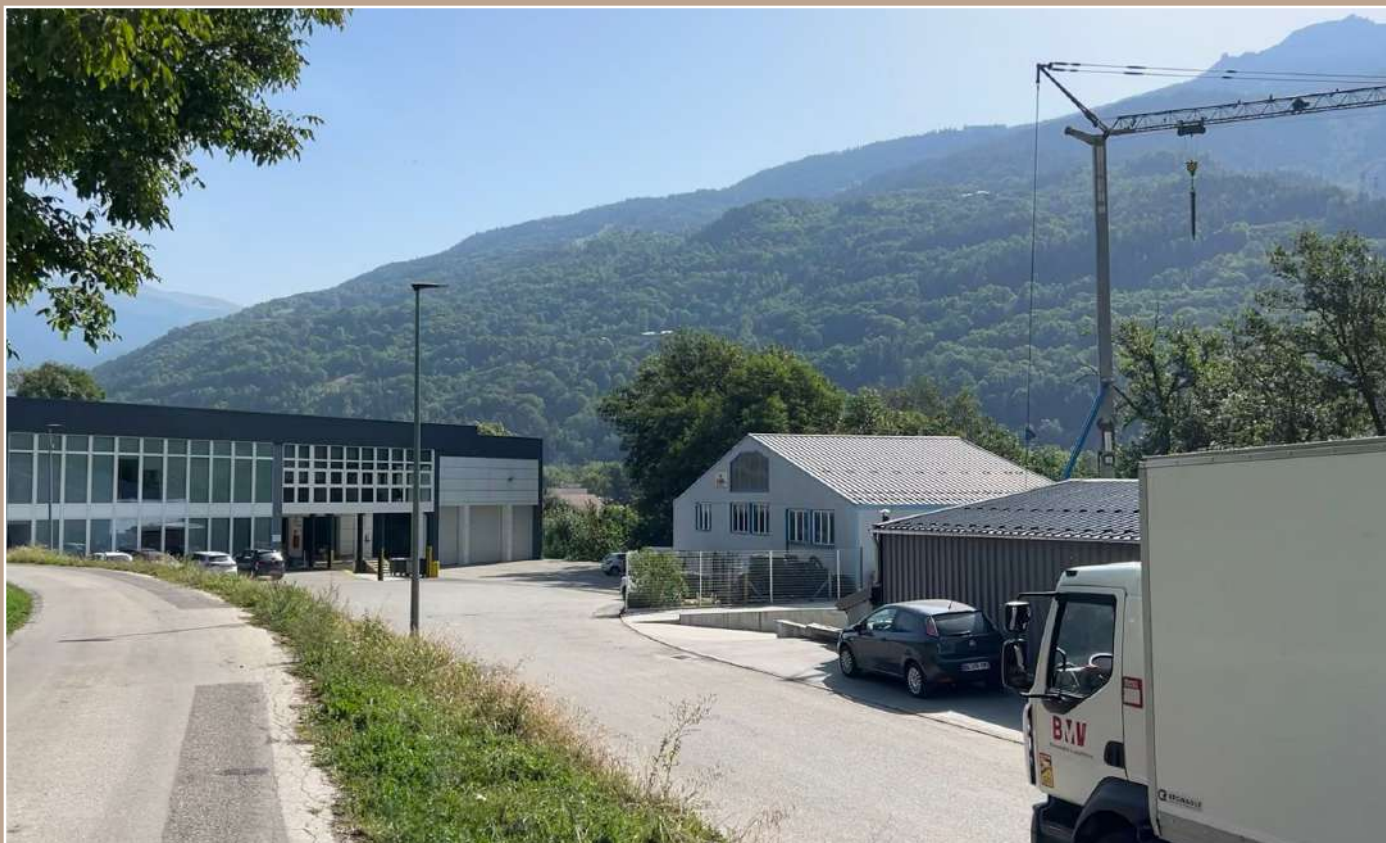
Zone d'Activité Economique des Colombières à Bourg Saint Maurice - Août 2025
