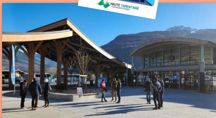
Mise en service du Pôle d'Echange Multimodal - Décembre 2025
