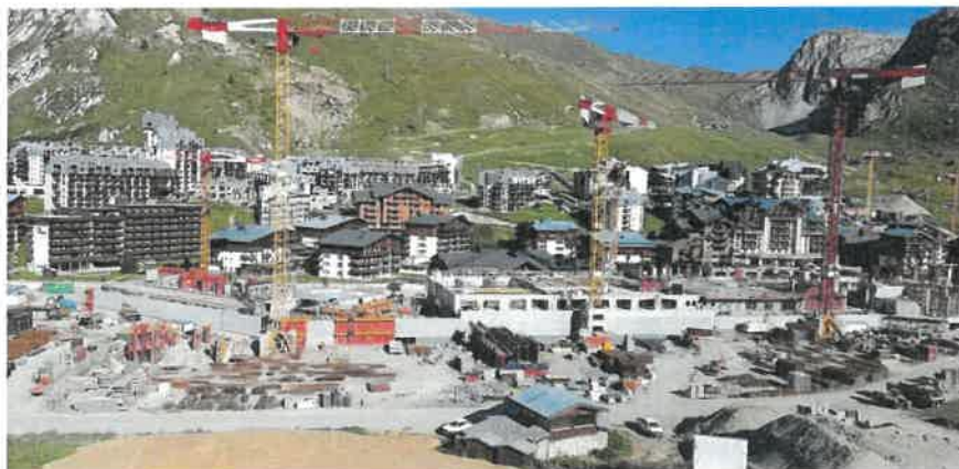
Figure 4 Exemple de chantier en cours à Tignes
